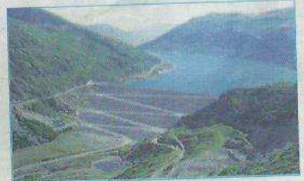
Barrage de Grand Maison
